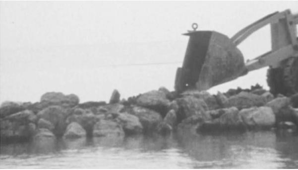
**Abb. 13:** Filmstill (wie Abb. 9): der Bagger verteilt die Basaltblöcke
